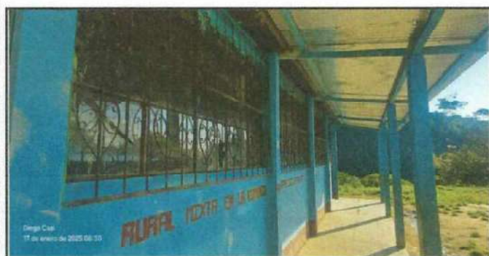
Foto 5: En esta fotografía se observa los balcones de la escuela que necesita su lijado y pintado.
